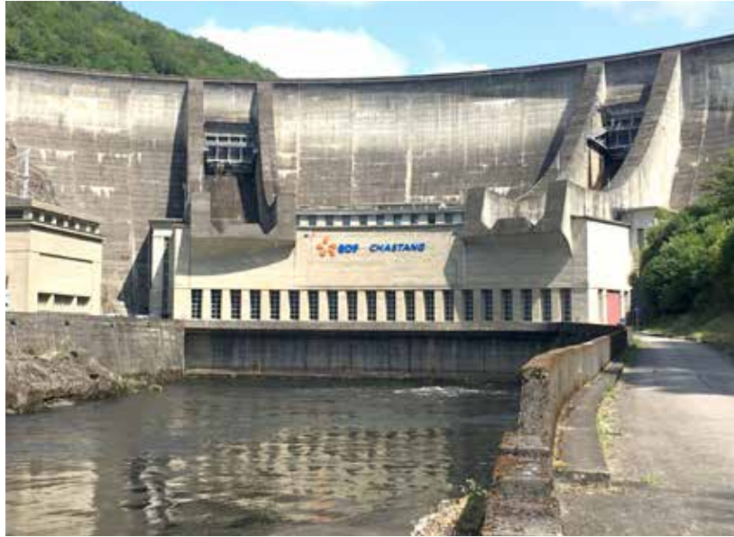
Le barrage du Chastang est l'un des derniers construits sur la partie corrézienne de la Dordogne. © M. Lemaître
