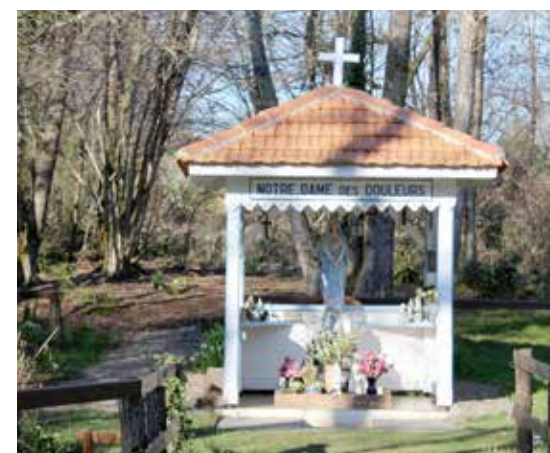
L'abri qui entoure la source de Morcenx-la-Nouvelle a été édifié entre 1992 et 1995. © V. Berthet
