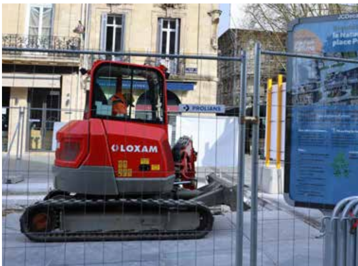
Des ouvriers sont à pied d'œuvre place Pey-Berland, à Bordeaux, pour casser le bitume. Une vingtaine d'arbres sera plantée pour revégétaliser cette place minérale. © O. Cuenoud
